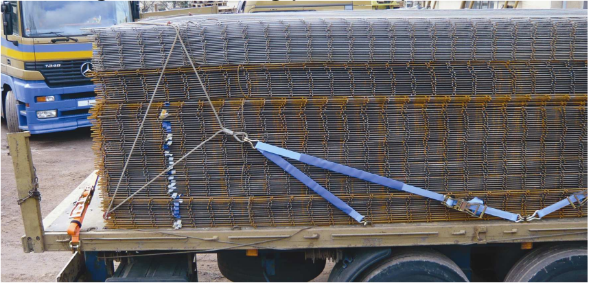
Abb. 15: Die Profilhaken des DoZurr 5000 in die Seilöse (Seilkausche) des Seilsystems einhängen sowie in die Zurrpunkte des Aufliegers
