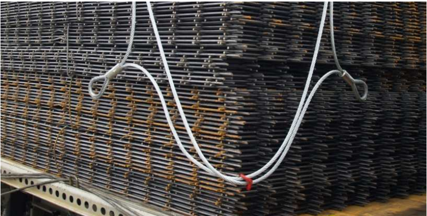
Abb. 12: Es wird empfohlen, dass möglichst alle Betonstahlmattenpakete von dem DoUniFlex-Seilsystem erfasst werden.
