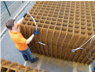
Abb. 9: DoUniFlex-Seilsystem über je eine Ecke des Betonstahlmattenstapels legen.
